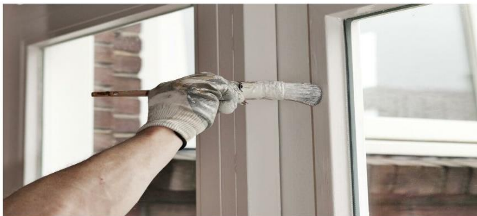
Рисунок 2 – Нанесение люминофора в отделочный материал.
